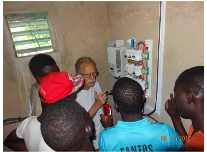
Mise en service
