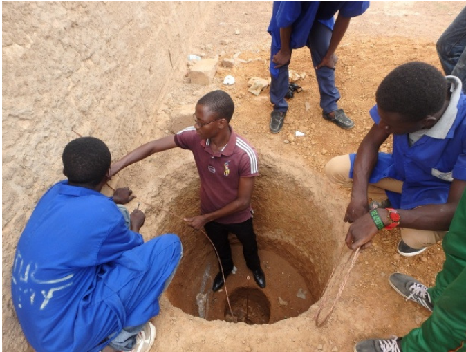
Réalisation du puits de terre suivant les standards locaux
